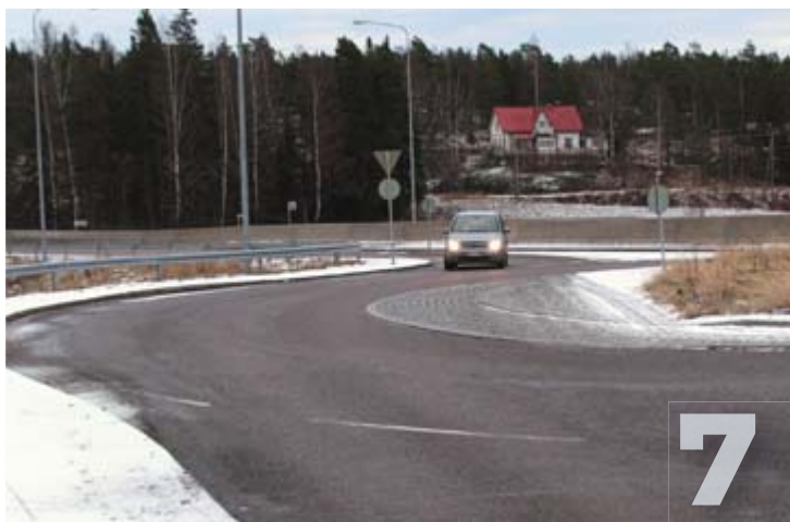
↑ KEHÄ III:n ja Itäväylän liittymässä todelliset ajolinjat ja liikennesuunnittelijoiden ajattelemat ajolinjat kulkevat eri kohdassa. Matala kivetys antaa tähän mahdollisuuden. Muiden esimerkki innoittaa yhä useamman oikaisemaan suoraan.
